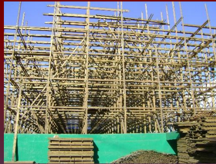
Instalación de la Estructura
