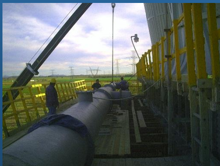
Instalación Cabezal de Distribución
