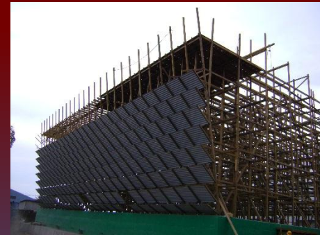
Instalación de louvers
