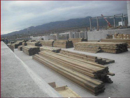
Preparación para la instalación
