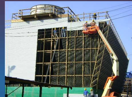
Colocación de Forros
